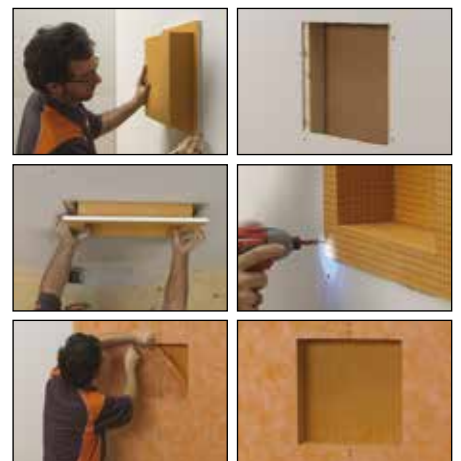
Instalación con paneles de cartón yeso:
